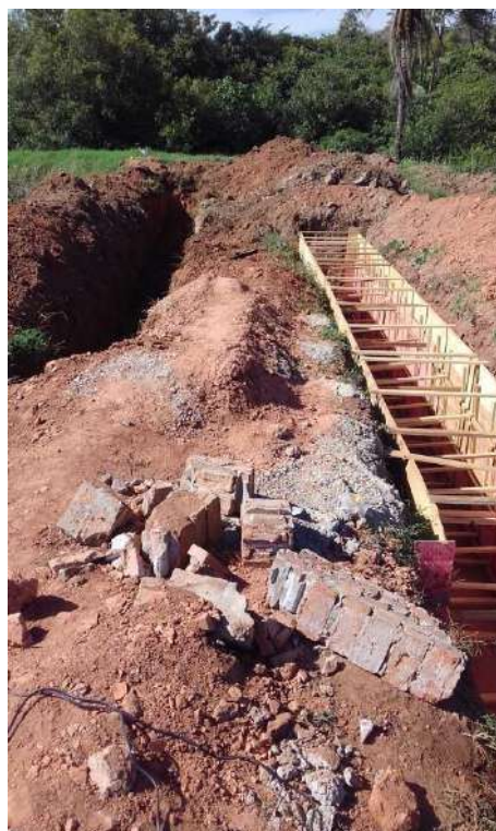
Foto 3.36 – Construção do tratamento preliminar
