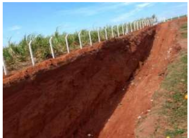
Foto 3.46 - Vista geral do novo aterro sanitário
