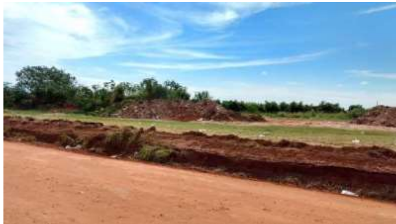
Foto 3.61 – Depósito de RCC
