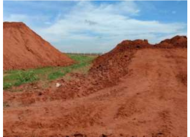
Foto 3.48 - Vista geral do novo aterro sanitário
