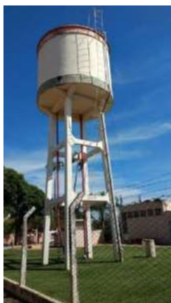
Foto 3.19 – Reservatório 4 (Poço 1 e Poço 7)
