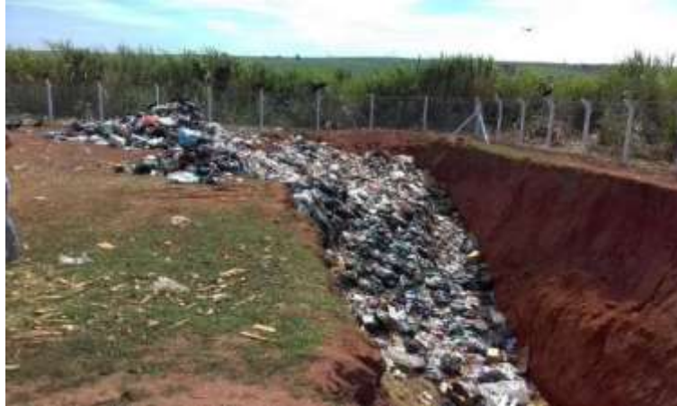
Foto 3.49 – Vista geral do novo aterro sanitário
