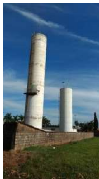
Foto 3.20 – Reservatório 2 e Reservatório 1
