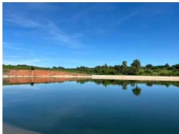
Foto 3.38 – Vista da ETE
