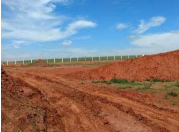
Foto 3.47 – Vista geral do novo aterro sanitário
